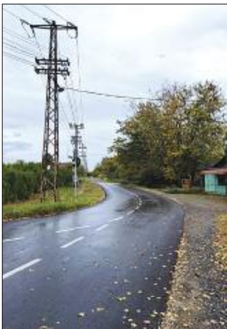
Asfaltirani deo Palmine ulice koji spaja Radnovačku sa Peščarinom ulicom
